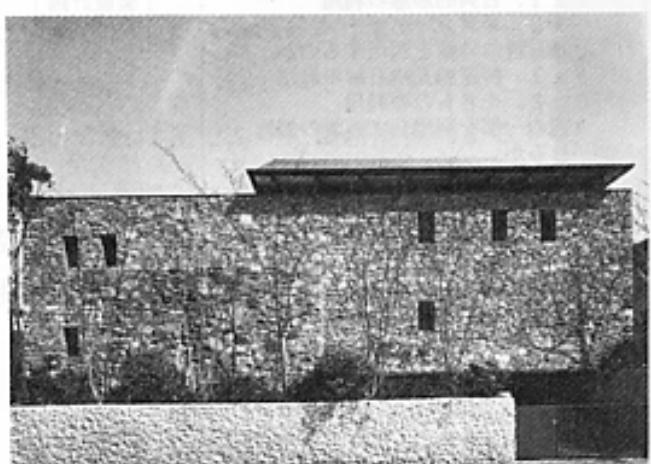
鉄筋コンクリート造に石積み
