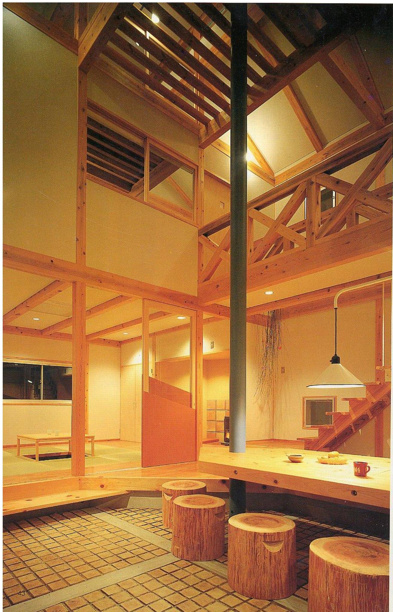
吹抜けの間から茶の間に向かって。暖炉や大テーブルに切った畳が裏で暖められた空気は、屋根裏に取り付けた熱交換空調換気扇で新鮮な暖気に変えられ、ブルーのパイプを通ってテーブル下へ。パイプはその機能と空間の象徴としての意味を持つ。
