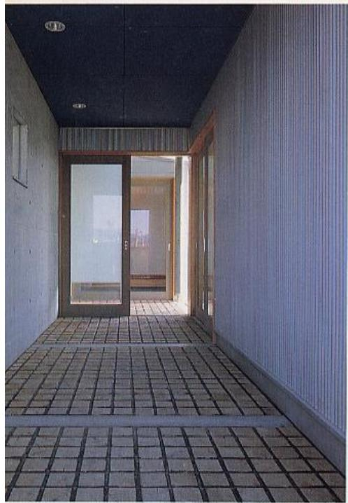
ポーチより離れ玄関方向を見る 右の壁はガルバリウム鋼板厚さ0.4mm小波板張り 左の壁はコンクリート打放し 天井は石膏板の上VP塗り
